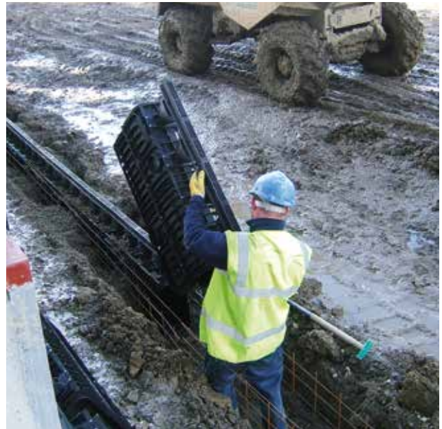
Elementos ligeros, instalados por un solo trabajador.
