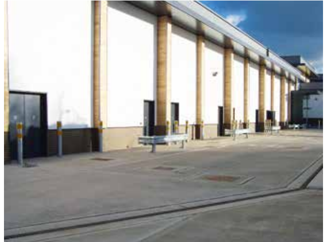
Instalación en superficie de hormigón
